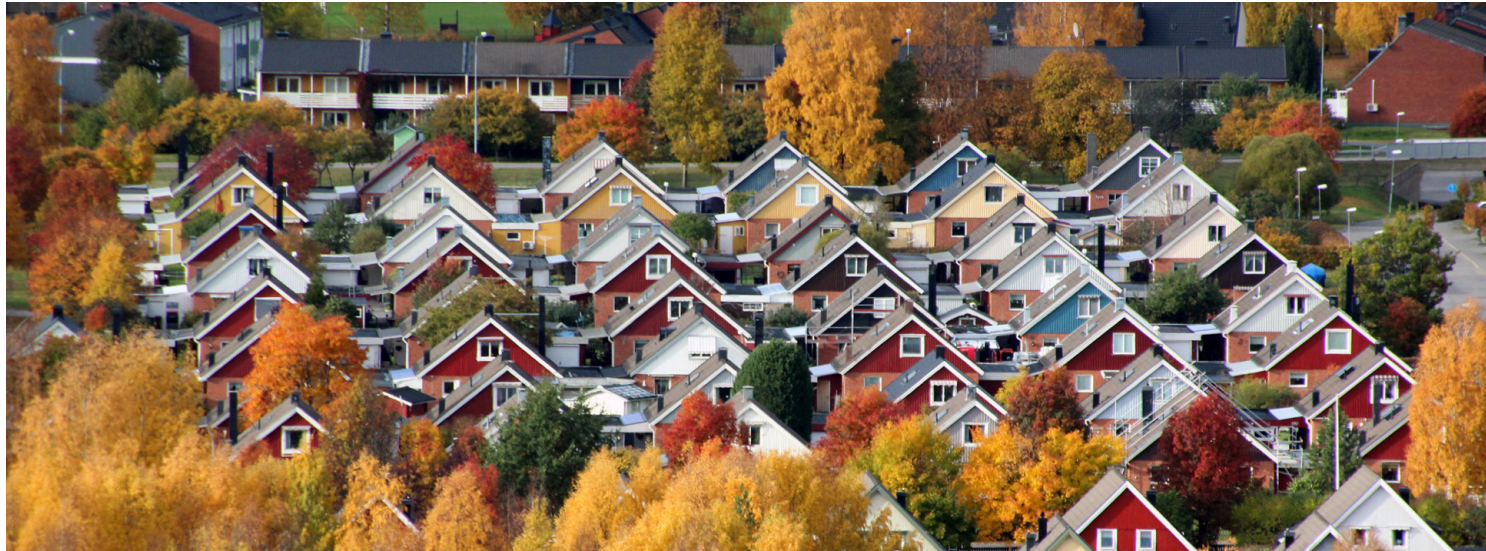
Vi säkerställer trygga leveranser av el, värme och kommunikation
