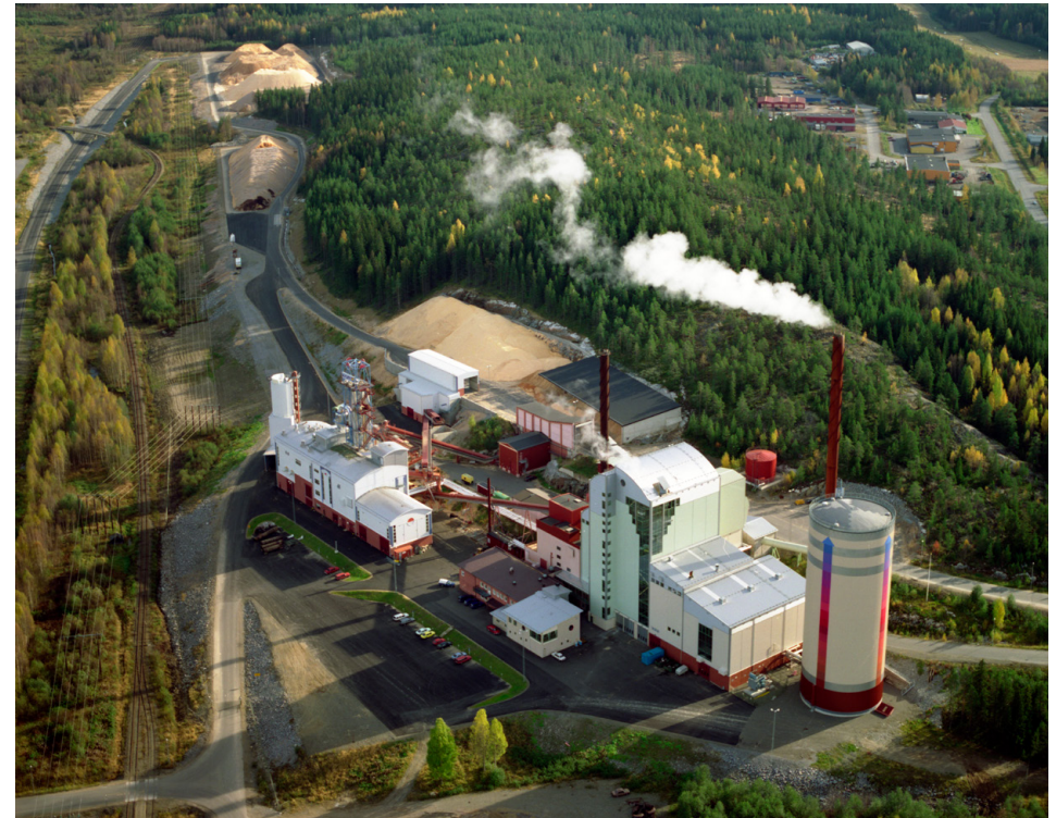
Skellefteå Kraft har beviljats tillstånd att avskilja koldioxid från rökgaserna vid Hedensbyns kraftvärmeverk
